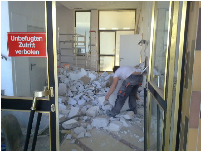
Abriss der Zwischenwand
