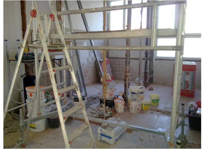
Hier waren die alten WCs
